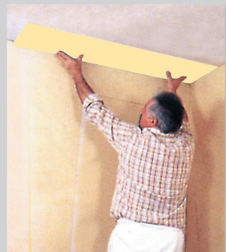
UNIVERSAL-Dämmkeil für Deckenzone und einbindende Innenwand
