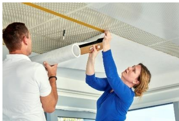
Cleaneo SYSTEXX Silent ansetzen am Silikonband
