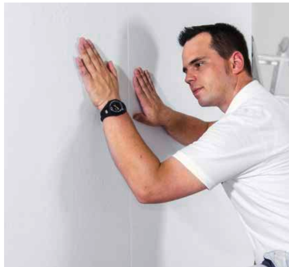
▲ Tapezierung auf Stoß möglich.
