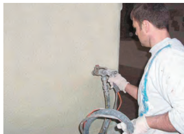
1. Putzauftrag maschinell
