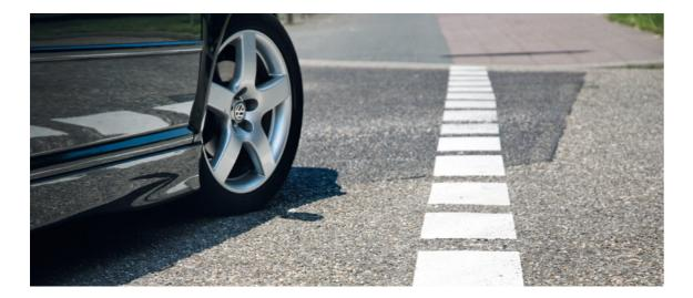
Stark belastete Straßen benötigen eine Markierung mit hoher Verschleißfestigkeit. Zudem kommt es auf ßerdem darauf, dass Sie nur Produkte mit BASt-Zu- ge Markierung mit hoher Retroreflexion. lassung verwenden. Gerade auf schlecht beleuchte-
