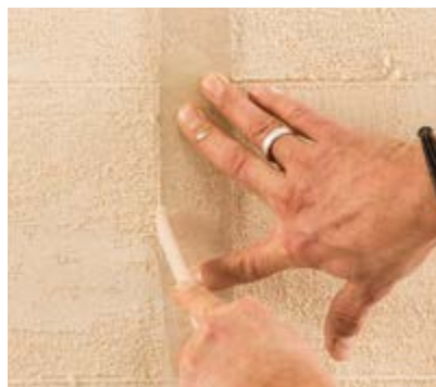
Fugen in das noch feuchte Material einritzen. Überschüssiges Material aus den Fugen abbürsten.
