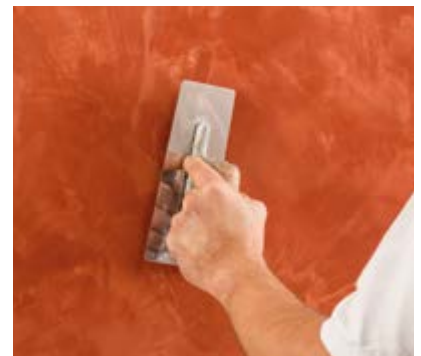
Fläche mit der Glättkelle unter Druck verpressen.
