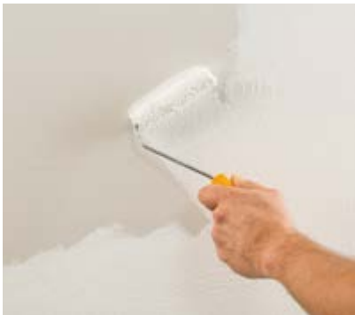
Grundieren mit Iso-Mineralgrund 309.
