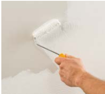
Grundieren der Fläche mit Jaeger Iso-Mineralgrund 309.
