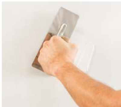
Stucco Fondo in 1–2 Lagen glatt spachteln, planschleifen (P320).
