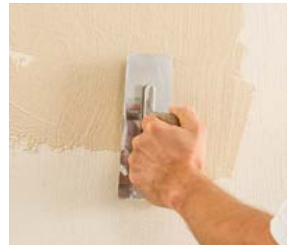
Nach Trocknung über Nacht 2. Lage Jaeger Travertino 930, mit der Glättkelle auftragen.
