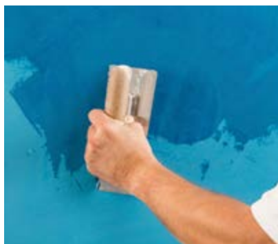
2. Lage Stucco Romano auftragen.
