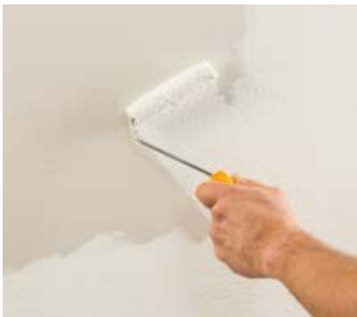
Grundieren mit Iso-Mineralgrund 309.
