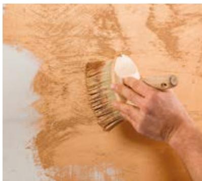
Jaeger Sabbia richtungslos auftragen.
