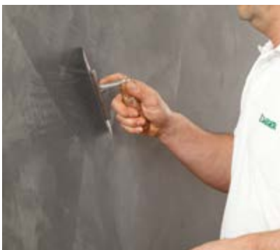
Fläche mit der Traufel verpressen.
