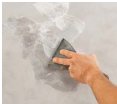
Kronen® Exquisit Finish dünn-schichtig in 1–2 Lagen aufspachteln.
