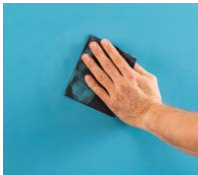
Fläche schleifen mit 320 er Schleifpapier.
