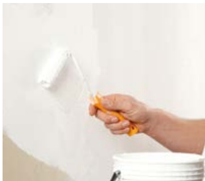
Grundieren der Fläche mit Jaeger Iso-Mineralgrund 309.
