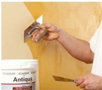
2. Lage Antiqua 968 eingetönt, leicht strukturiert.
