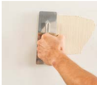
1. Lage Jaeger Travertino 930 mit der Glättkelle auftragen.
