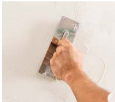
Eine Lage Antiqua Kalkputz mit der Traufel auftragen.
