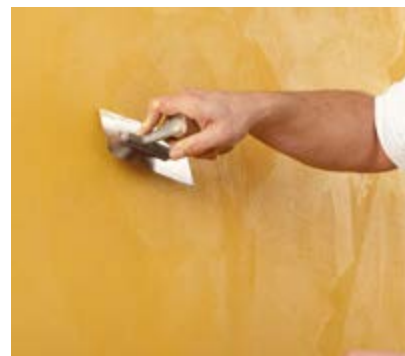
Fläche mit der Traufel verpressen.
