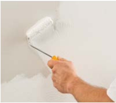
Grundieren mit Iso-Mineralgrund 309.
