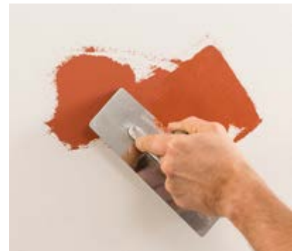
Fresco Veneziano gefleckt mit der Glättkelle aufspachteln.
