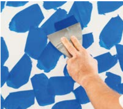
1. Lage Stucco Veneziano in Fleckspachtelung auftragen.
