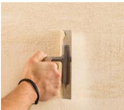
Nach einer Abluftzeit von ca. 30 min die Oberfläche mithilfe der Kelle „aufreißen“: Oberfläche mit der Traufel nochmals verpressen.
