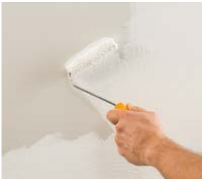
Grundieren der Fläche mit Jaeger Iso-Mineralgrund 309.
