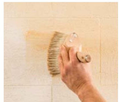
Die Oberfläche kann mit Jaeger Antik-Seife behandelt werden.
