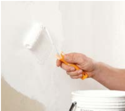
Grundieren der Fläche mit Iso-Mineralgrund 309.
