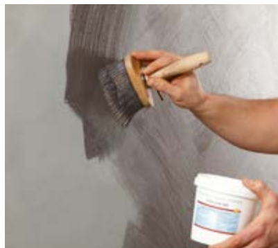
Auftrag der eingefärbten Antik Seife 985 mit einem Pinsel oder der Kelle.
