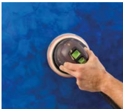
Polieren mit Festool Getriebe-Exzentrerschleifer Rotex RO 150 FEQ. Alternativ kann manuell mit der Spachtel poliert werden.
