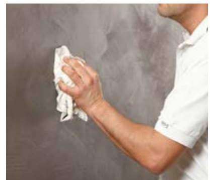
Überschüssige Seife mit einem Baumwolllappen aufnehmen.
