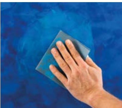
3. Lage Stucco Veneziano, anschließend schleifen (P1200).
