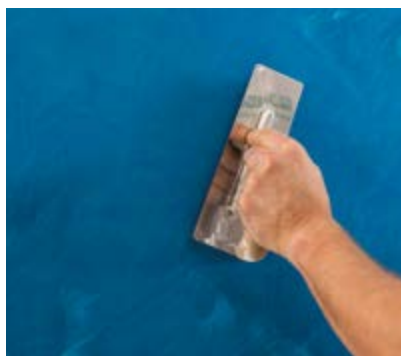
Polieren der Fläche mit der Traufel oder dem Getriebe-Exzentrerschleifer Rotex RO 150 FEQ von Festool.
