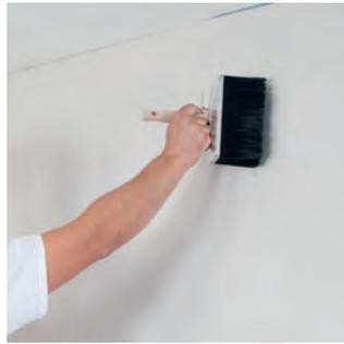
Geeignet sind alle Wand- und Deckenflächen, die fachgerecht ausgeführt sind. Die Untergründe müssen trocken, tragfähig, sauber, eben, glatt und saugfähig sein.
