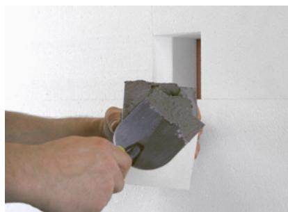
Auf die Klebefläche des Montagequaders Quadroline®-EPS Klebemörtel aufziehen. Element muss vollflächig auf den tragfähigen Untergrund verklebt werden.
