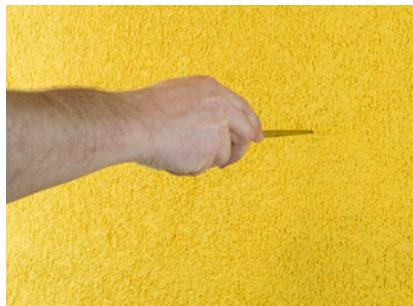
Anbauteil im Montagequader Quadroline®-EPS verschrauben.
