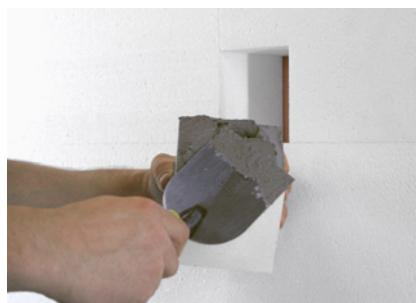
Applicare della malta adesiva sulla superficie d'incollaggio del blocco di montaggio Quadroline®-EPS. L'elemento deve essere incollato coprendo la totalità della superficie sul fondo portante.
