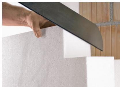
Si raccomanda di posare i blocchi di montaggio Quadroline®-EPS contemporaneamente all'incollaggio dei pannelli isolanti.
