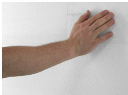
Montagequader Quadroline®-EPS dämmplattenbündig anpressen.
