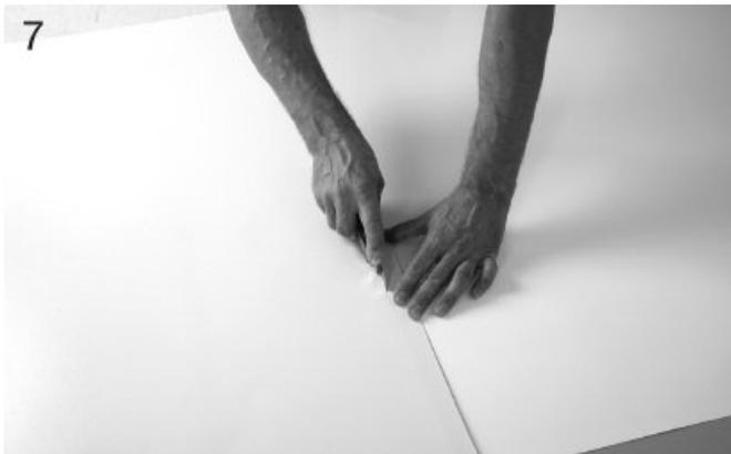
7 Doppelschnitt: Zwei Bahnen leicht überlappen lassen und mit einem Cuttermesser durch beide Bahnen durchschneiden.
