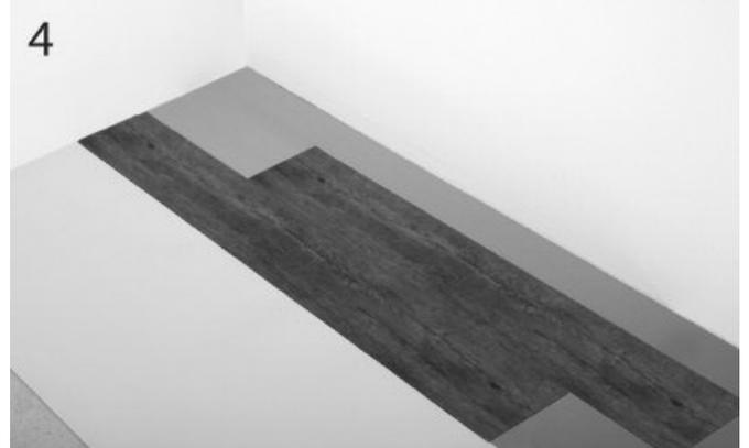
4 Weitere Diele mit Versatz parallel an die erste Diele passgenau anlegen. Schutzfolie nach Bedarf Stück für Stück flach abziehen.
