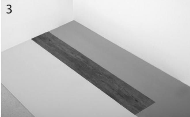
3 Die erste Diele des Bodens entlang der Schutzfolie an der Bahnmitte auflegen.
