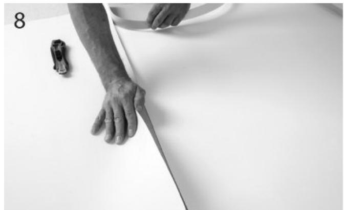
8 Überstände nach dem Doppelschnitt entfernen. Doppelschnitt auch am Ende einer Bahn beim Anlegen der nächsten Bahn anwenden.
