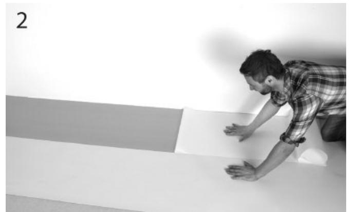
2 Die wandseitige Bahn der Schutzfolie zunächst ein Stück flach abziehen.
