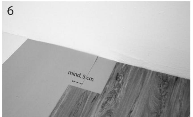
6 Die nächste Bahn der Unterlage wird angelegt und ein Teil der Schutzfolie abgezogen. Der Boden muss die beiden Bahnen jeweils um mindestens 5 cm überlappen. Ggf. ist die Unterlage mittels Doppelschnitt anzupassen.
