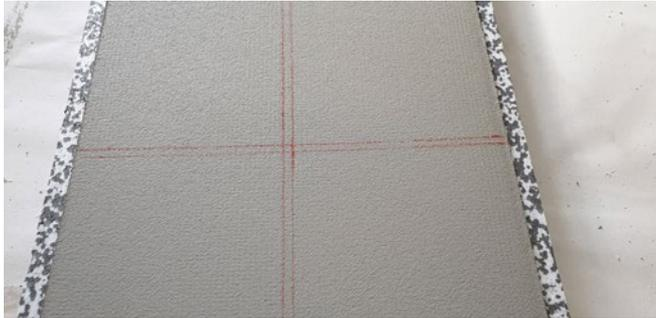
1. Objektspezifische Fugenplanung ist zu berücksichtigen. Feldbegrenzungsfuge auf Armierungsschicht anzeichnen (Breite je nach Dimensionierung). Hier am Beispiel als Ausführung einer Kreuzfuge.
