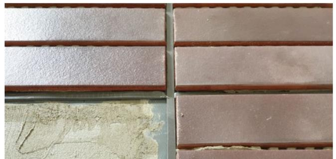
**16.** Je nach Dimensionierung und Fugentiefe Elastozellband oder PE-Rundschnur über das Capatect Fugenband FBF 044 einlegen. Die Dimensionierung ist in Abhängigkeit der Dicke des Hartbelages zu wählen.
