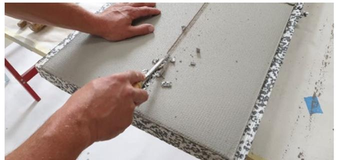
4. Armierungsschicht mit Gewebe bis zur Dämmstoffebene herausnehmen z. B. mit Stukkateureisen. Dämmstoff v-förmig einschneiden und entfernen.
