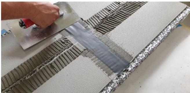
9. Capatect Fugenband FBF 044 im Bereich der Feldbegrenzungsfuge mittig über die durchtrennte Armierungsschicht ausrichten und in den Verlegemörtel (Zahntraufel 6x6) einbetten. Das Band ist vorzugsweise mit einer Glättkelle einzuspachten, überschüssiges Material mit mittlerem Druck über den Gewebeträger des Fugenbandes abziehen.
