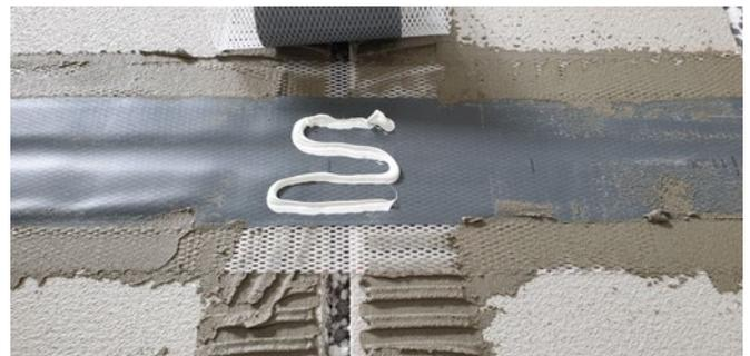
10. Notwendige Überlappungen z. B. im Stoßbereich werden mit elastischer Fugenmasse verklebt. Die Fugenmasse wird rautenförmig im Abstand von ca. 2 cm auf die unterste Lage des Fugenbands aufgespritzt und die übereinanderliegenden Fugenbänder durch leichtes Andrücken miteinander verbunden.
