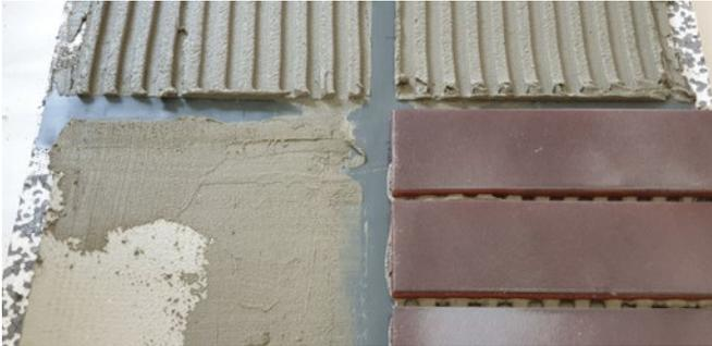
**13.** Klinkerriemchen im Buttering Floating-Verfahren verkleben. Fugenbereich muss ausgespart werden.
