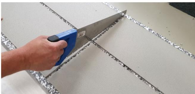
5. Dämmstoffentlastungsschnitt durchführen und Material entfernen, bis ca. Dämmstoffmitte. (dabei wird bis ca. zur Mitte der Dämmstoffdicke tief eingeschnitten)
