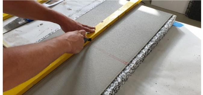
2. Armierungsschicht mit Cuttermesser oder geeignetem Werkzeug z. B. Vibrationschneider durchtrennen.
