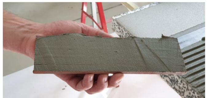
12. Um mit der Verlegung des Hartbelages beginnen zu können, muss der im vorherigen Arbeitsschritt verwendete Verlegemörtel erhärtet und tragfähig sein.
