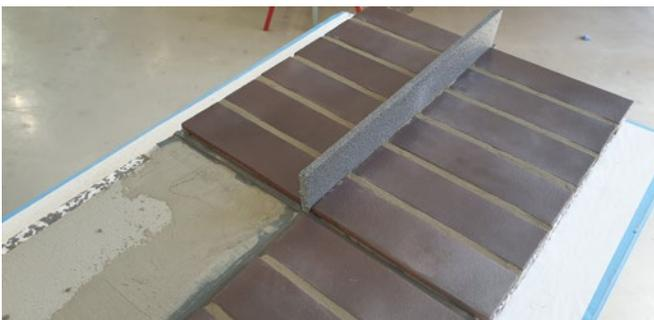
**15.** Capatect Fugenmörtel oder -schlämme Keramik in Fugen einbringen. Der Bereich der Feldbegrenzungsfugen muss ausgespart werden.
