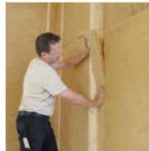
Größere lichte Weiten können durch Querverlegung der Platten gefüllt werden. Um Verschnitt zu vermeiden, kann das Reststück einer Platte mit einer neuen Platte zusammen ins Gefach gedrückt werden. = ENDLOSVERLEGUNG
