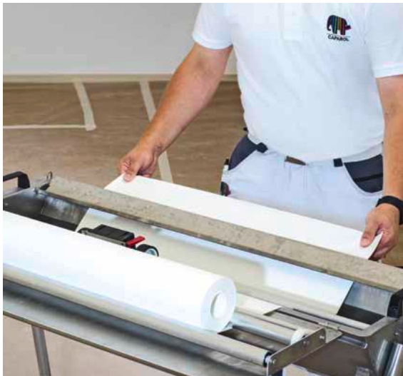
▲ Verarbeitung mit handelsüblichen Wasserbadgeräten mit Abstreifer.
