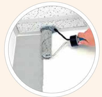
Sauber und einfach ohne Abkleben in einem Arbeitsgang streichen
