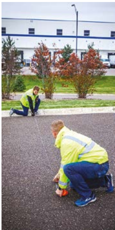
Herkömmliche Methode: Eine Schnurlinie, Kreide und 2 Personen sind notwendig
