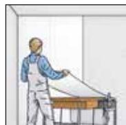
2a. Оклейивать с помощью клеенамазочного станка без пропитки или
