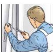
6. На внутренних и на внешних углах обойное полотно обрезать, следующее полотно наклеивая встык.
