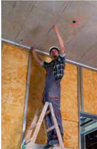
▲ Transfer des Layouts von der Bodenplatte an Wände und Decken.
