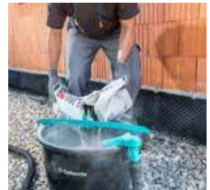
Durch Auflegen des Materialsacks auf die Zähne des SHARKY entsteht eine saubere Öffnung, egal ob Papier- oder Kunststoff sack.
