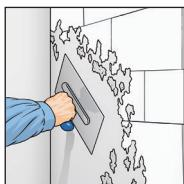
1. Удалить старые обои и покрытия. Шероховатые основания выровнять гипсокартонной шпаклевкой. На сильно впитывающие основания нанести грунтовку, не содержащую растворителей.
