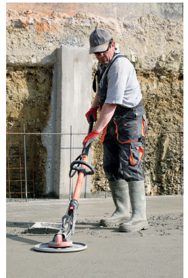
Egalisieren von Betonflächen
