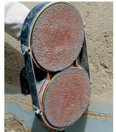
Aggressives Schleifen mit HMT-Scheiben
