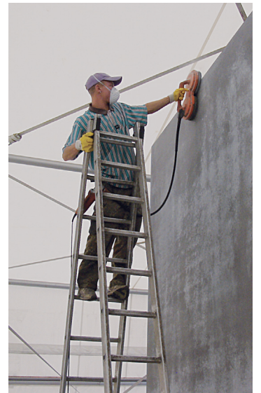
Sichtbeton polieren am Holocaust Denkmal
