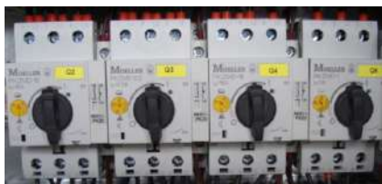
Abb. 5: Motorschutzschalter
