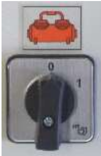
Abb. 20: Wahlschalter Luftkompressor
