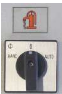
Abb. 19: Wahlschalter Druckerhöhungspumpe
