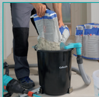
Behalten Sie den Durchblick mit DUST.ex und einem Entstauber der Filterklasse »M«.
