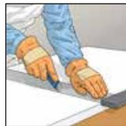
**2.** Dämmkeil mit Cutter anritzen und über Kante brechen oder mit einer Säge zuschneiden.
