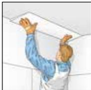
**4.** Dämmkeile nebeneinander mit mäßigem Druck an Wand bzw. Decke anpressen. Überschüssigen Kleber an den Rändern entfernen.
