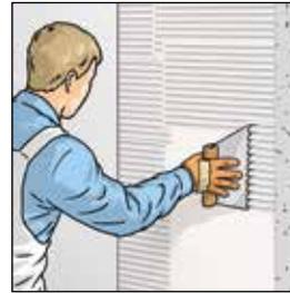
Zur Verklebung ERFURT-Systemkleber SR 4 mit dem Zahnschachtel (je nach Untergrund Größe C3, B2) quer zur Laufrichtung gleichmäßig verteilen. Um Haftungsproblemen vorzubeugen, den Kleber nicht zu dünn auftragen und nicht zuviel Fläche (etwas mehr als Bahnenbreite) auf einmal beschichten.
