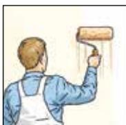
**9.** Innen-Dämmplatte mit Kleister grundieren.
